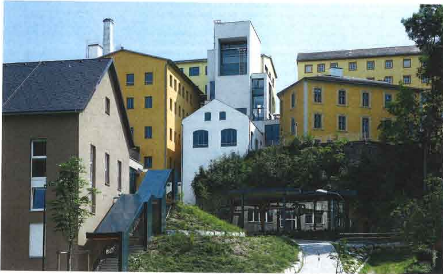
Das revitalisierte Vonwiller-Areal (2005–2009)
